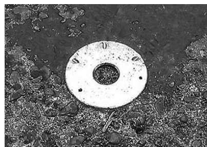
写真－2 散水機能が低下した消雪パイプ
