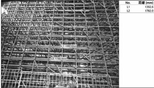
写真-9 重ね継手長計測の表示例
