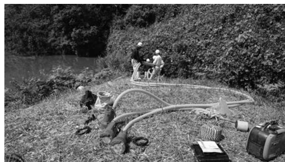
写真－3 \phi 100 mm は全ての部材が人力運搬可能
