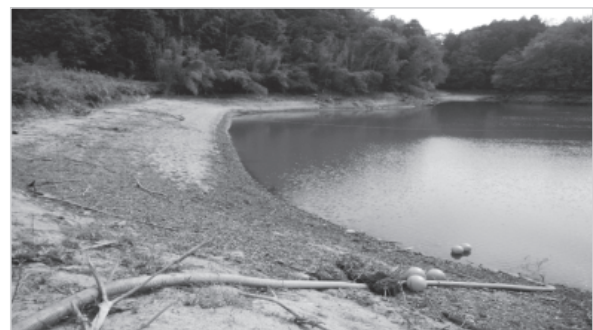
写真-7 広大なため池でも、φ100mmサイフォン1台を使用して24時間で25mプール8面分以上を放流した
