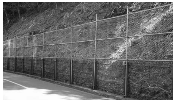
写真－1 既設落石防護柵の応急処置例
