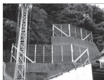
施工後（かさ上げ）
