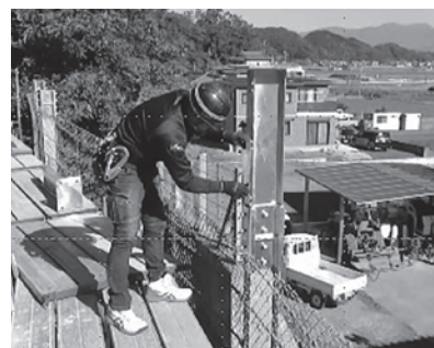
図-5 スترونガー工法の施工状況
