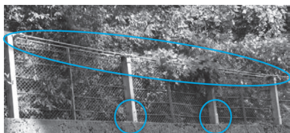
写真－６ 支柱上部及び下部の補強設置状況
