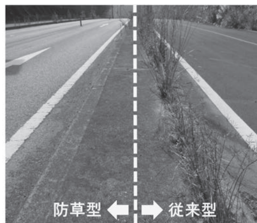
平成 27 年 11 月（施工後 8 年 5 カ月経過）
