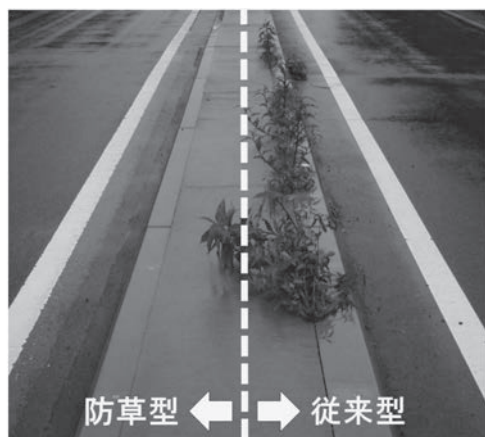
平成 20 年 6 月（施工後 1 年経過）
