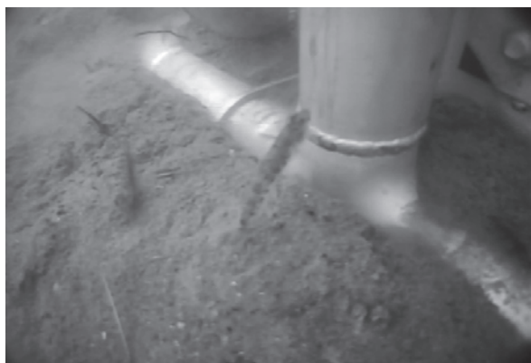
写真－１ 浚渫時の装置周辺の状況
