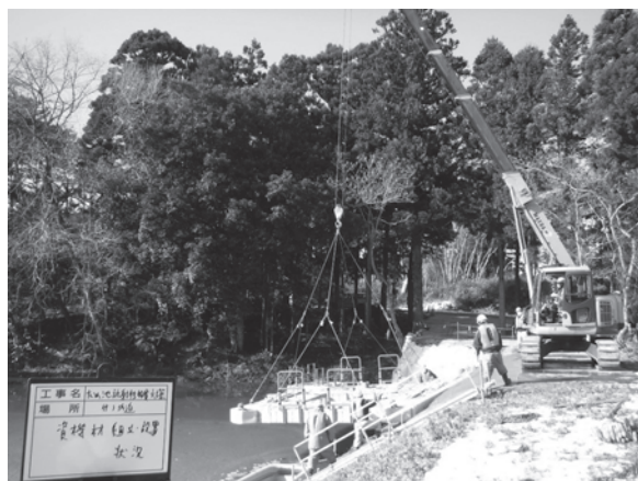
写真－２ 組立式台船進水状況
