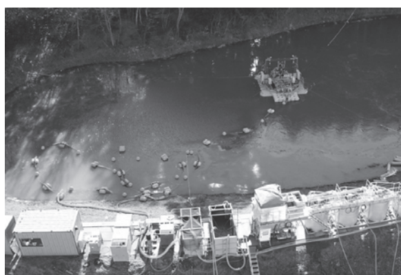
写真－３ 機材配置状況
