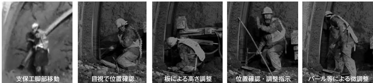
写真-2 現行の鋼製支保工脚部における作業フロー（切羽左側）
