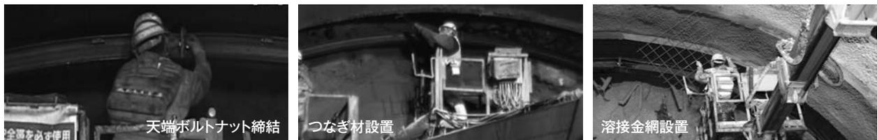
写真-3 現行の鋼製支保工天端部における作業フロー
