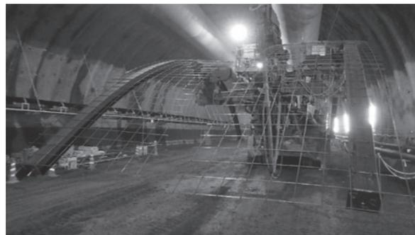
写真－9 溶接金網取付完了
