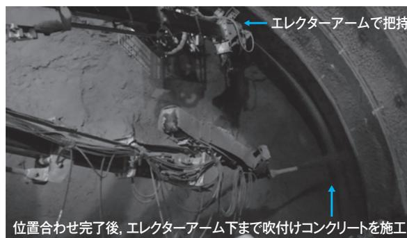
写真－11 右側鋼製支保工脚部固定状況
