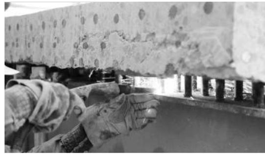
写真-6 ずれ止め(スタッド)の切断
