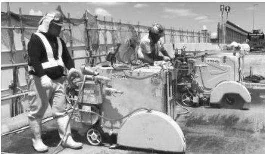
写真-4 コンクリートカッターでの床版切断
