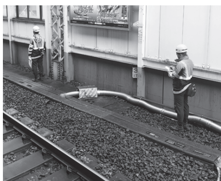
写真－2 徒歩巡視の状況
