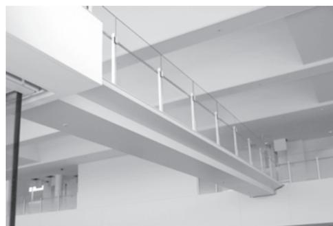
写真－2 無鉄筋のプレストレス人道橋の利用例
