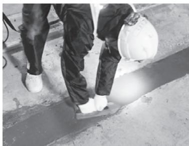
写真-10 PCa 道路床版接合仕上げ作業
