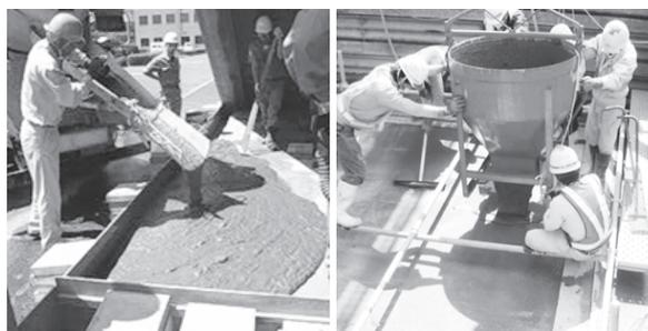
写真-3 スリムクリートの打込み状況
