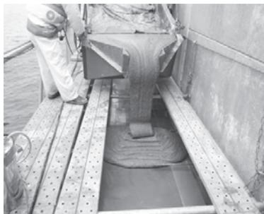
写真-5 型枠への流し込み状況
