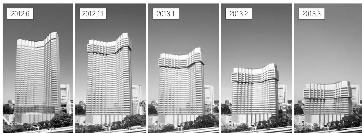
写真－3 テコレップシステムでの解体工事進捗状況（外観）
