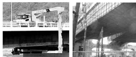
橋梁点検車・仮設吊足場による点検
