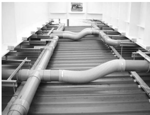
写真-2 チタンカバープレート内面と除湿配管
