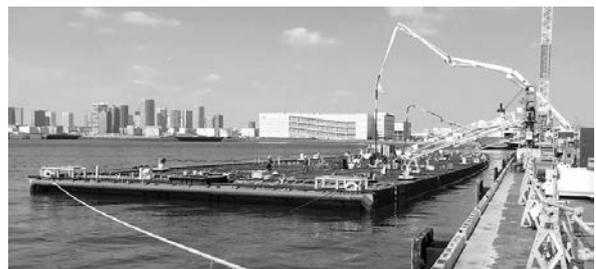
写真-7 6号函本体コンクリート打設状況
