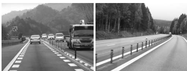
写真-1 暫定2車線道路（左：紀勢道）と2+1車線道路（右：スウェーデン）
