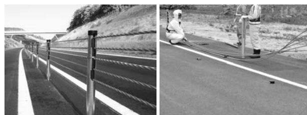
写真-2 ワイヤロープ式防護柵と開口部設置
