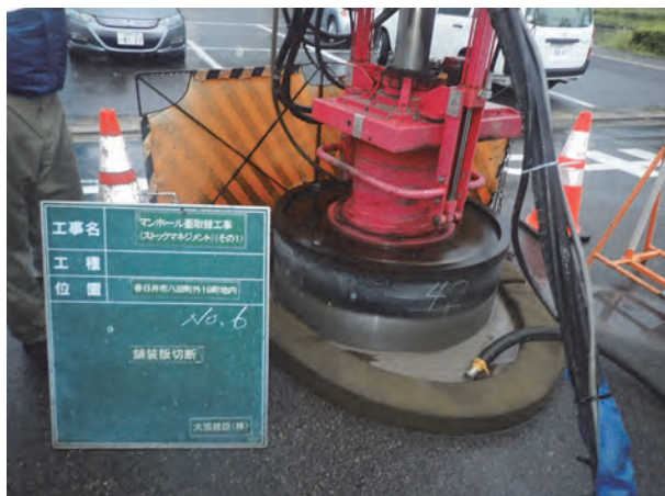
写真ー3 円形カッター切断状況
