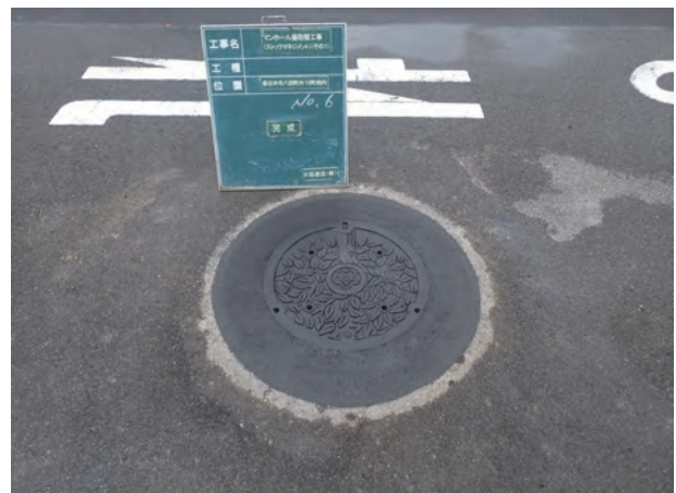
写真ー4 施工完了
