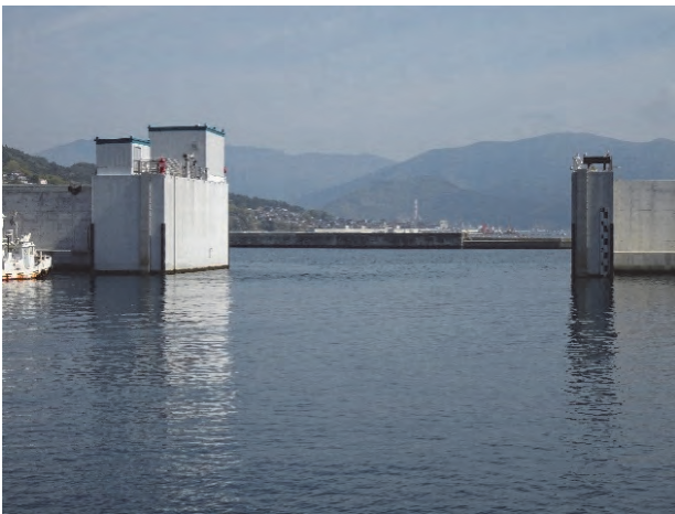
写真一 施工完成例
