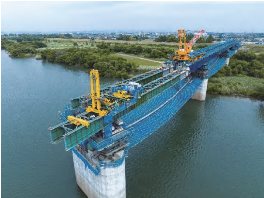
写真一1 手延機解体装置
