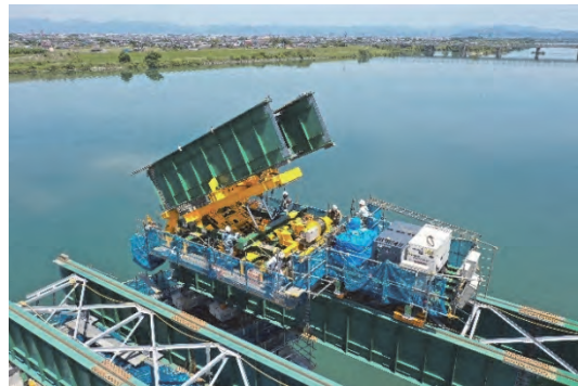
写真一2 後転・搭載状況
