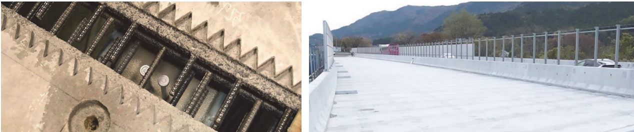
写真－2 UFC 複合床版接合部（間詰め UFC 打設前） 写真－3 UFC 複合床版架設完了状況
