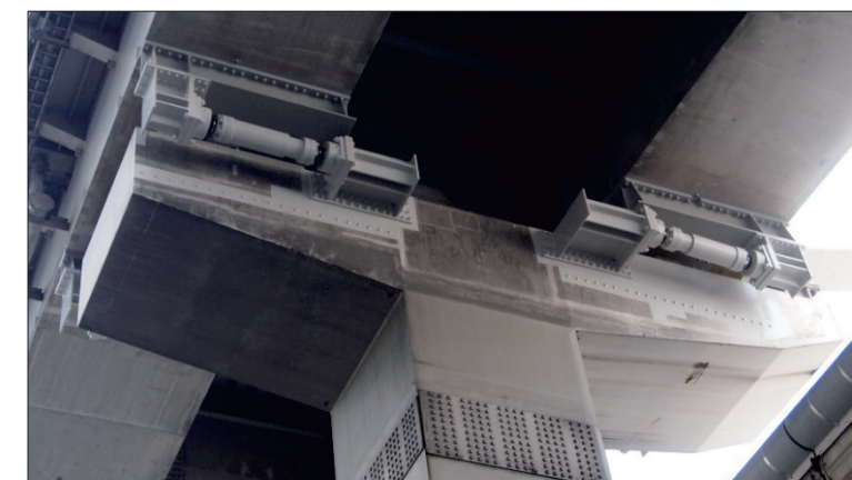
写真-2 DRF-DP設置完了(拡大)
