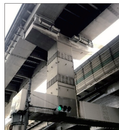
写真-1 DRF-DP設置完了(全景)
