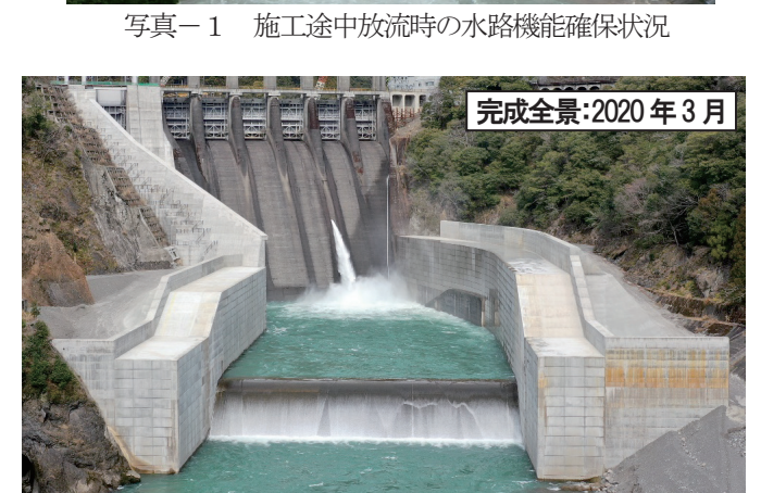
写真－2 長安口ダム施設改造工事 減勢工完成全景
