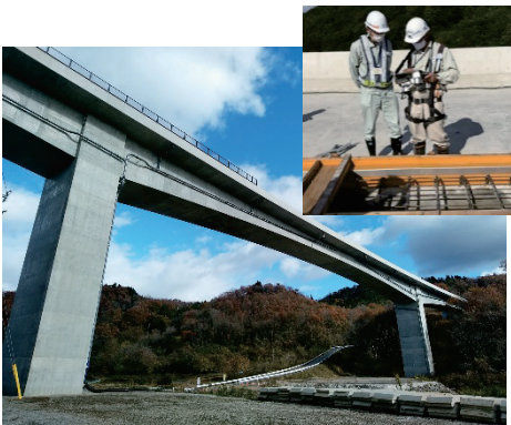
写真－5 発注者段階確認状況（東根川橋）
