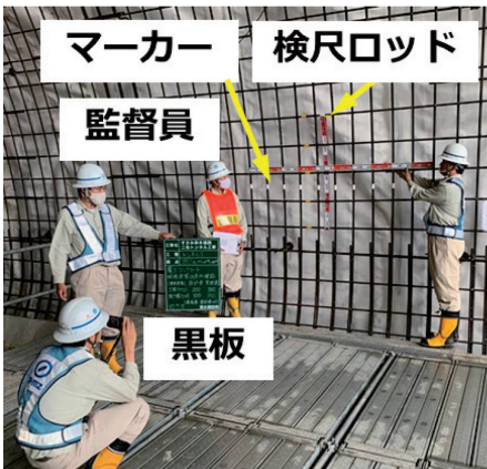
写真－1 従来の配筋検査状況
