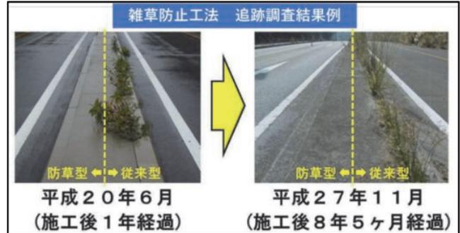
写真-1 スリムスリット(JS形)側溝(雑草防止工法)
