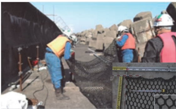
※陸側パラペット 写真-1 施工状況
