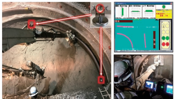
写真ー2 ナビゲーションによる右側鋼製支保工位置合わせ状況
