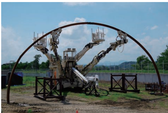
写真ー1 鋼製支保工建込みロボットの全景
