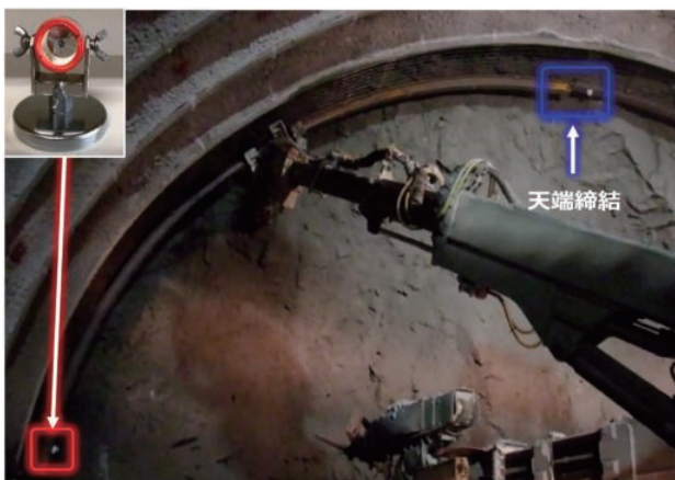
写真ー3 天端締結および左側鋼製支保工位置合わせ状況
