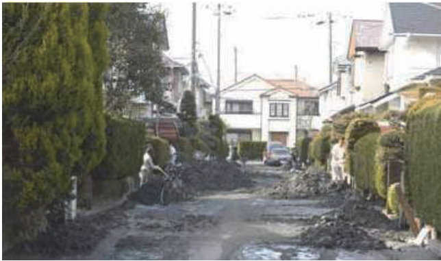
写真-1 東日本大震災における宅地液状化
