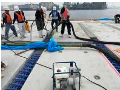
写真一4 コンクリート打設状況
