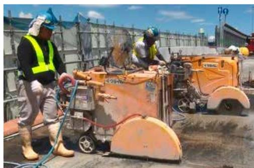
写真-5 コンクリートカッターでの切断
