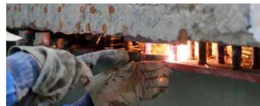
写真-3 ずれ止め(スタッド)の切断
