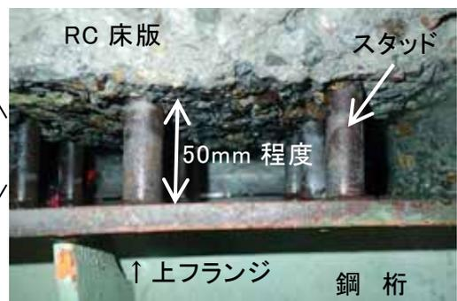
写真-2 接合部の除去状況
