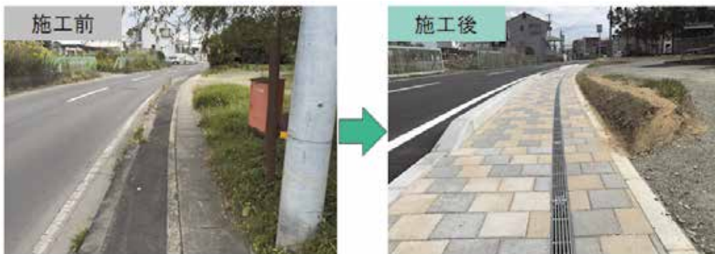
写真-3 景観に配慮した埋設型製品の施工例
