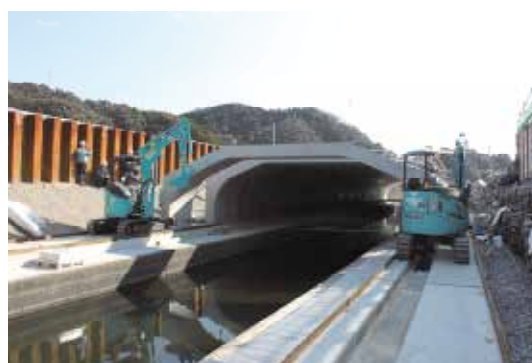
写真一4 門型カルバート
