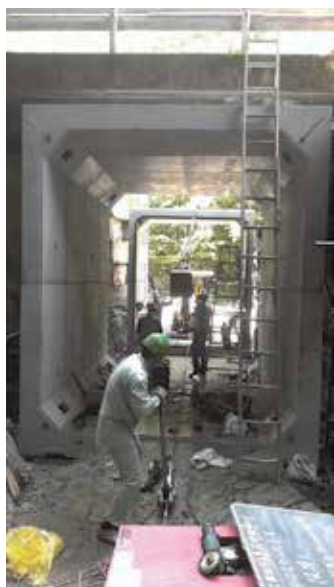
写真一3 BOXによる橋梁補修
