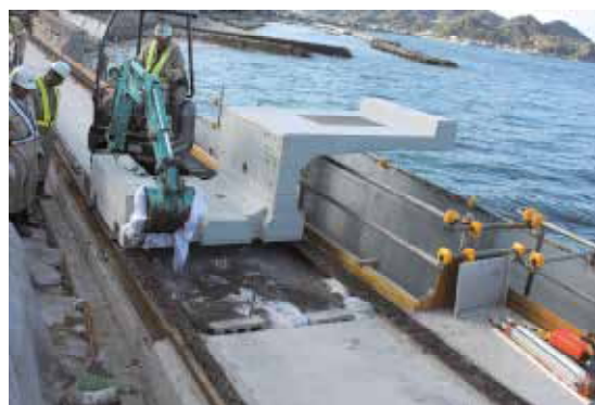
写真一2 張出歩道
