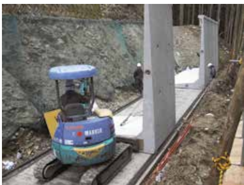
写真一1 L型擁壁
