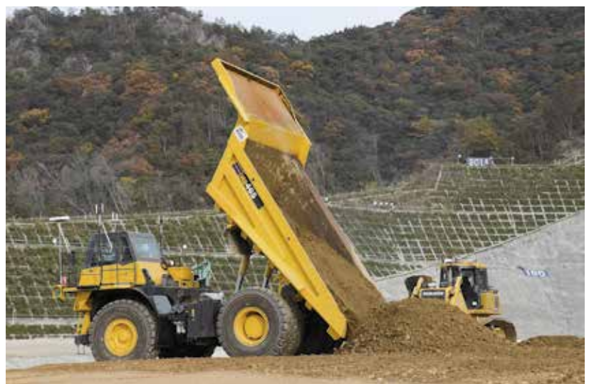
写真一1 大分川ダムの堤体盛立工事
