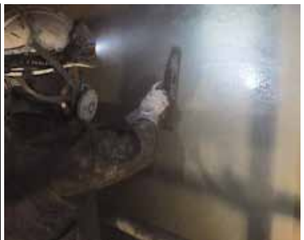
写真-9 改良①/仕上げ状況
