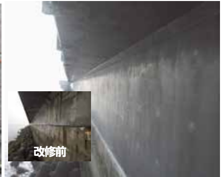
写真-3 本技術/施工完了 (無筋)
