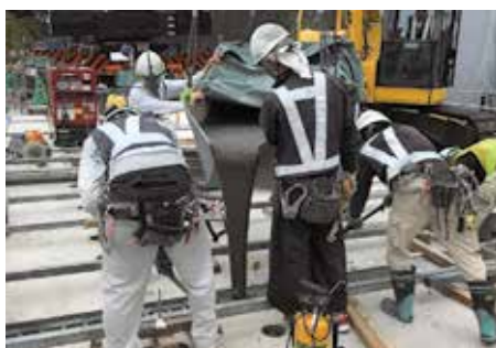
写真-10 改良②/床版接合状況
