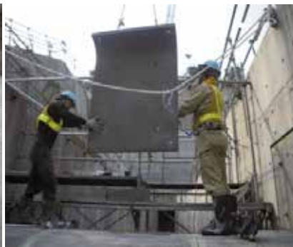
写真-5 本技術/製品設置
