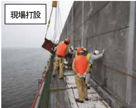
写真-1 本技術/現場施工
