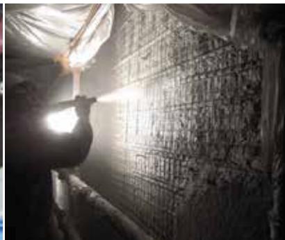
写真-8 改良①/湿式吹付け状況
