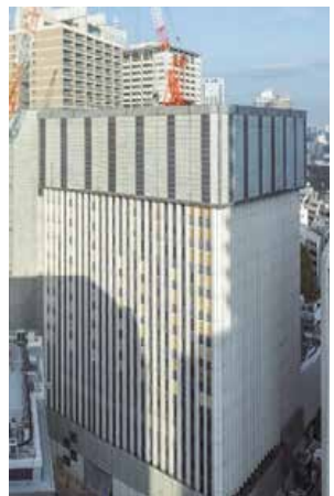
実績2 赤坂ツインタワー （66m）一部閉鎖
