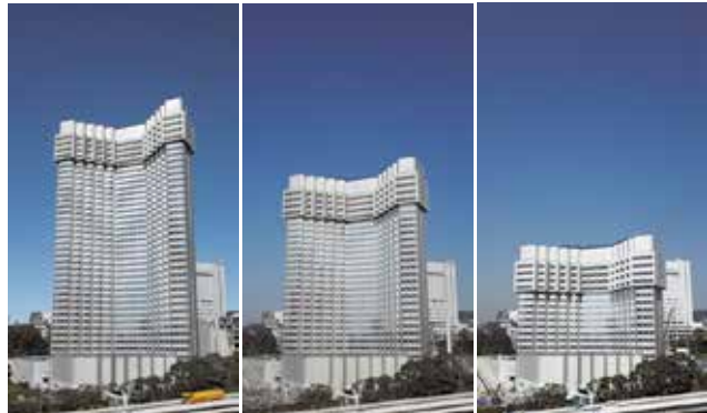
写真—2 テコレップシステムで超高層ビルが解体されて 縮んでいく様子（グランドプリンスホテル赤坂）
