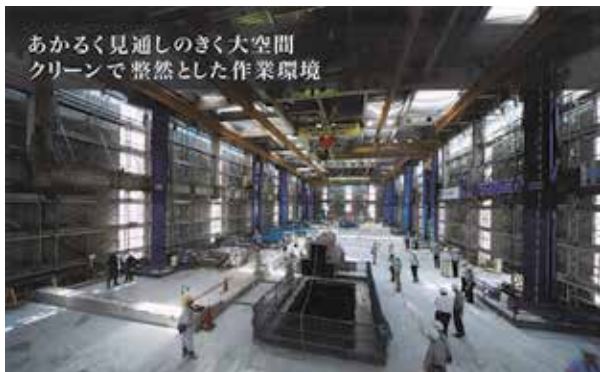
写真—1 テコレップシステムの閉鎖型解体空間 （解体作業に適した大空間を解体建物の頂部に構築）
