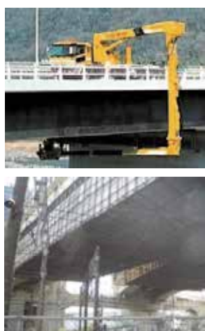
写真—1 道路橋へのガ-プレート工法の適用例と近接目視点検状況
