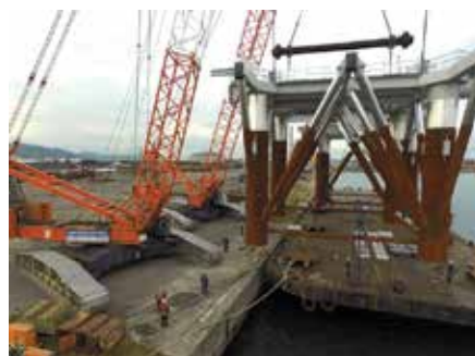
写真—1 道路橋へのガ-プレート工法の適用例と近接目視点検状況
