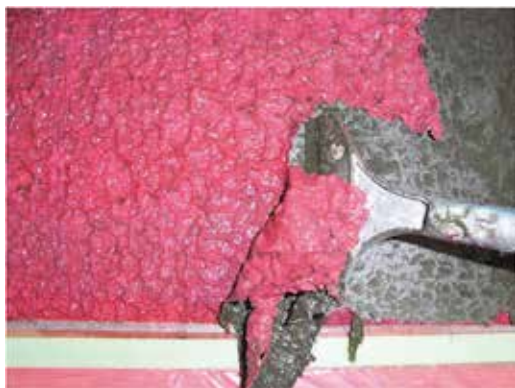
写真-3 スクレーパーによる塗膜除去
