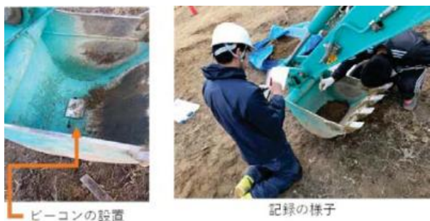
図13 beacon の設置状況と実験状況
