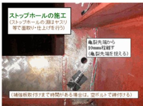
図1 ストップホールによる応急補修<sup>4)</sup>
