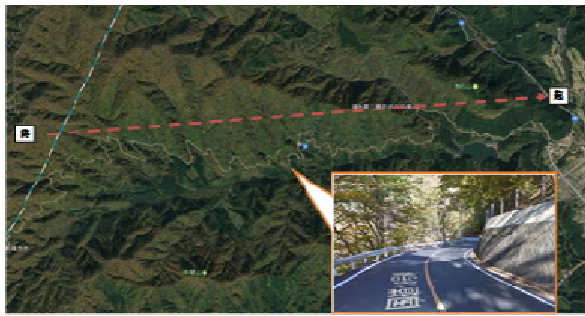
図-10 50km/h 未達成区間の道路状況(区間⑧)
