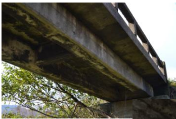
・桁下(1径間目)
