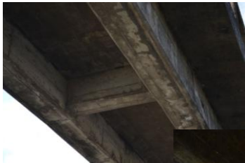
・桁下(3径間目)
