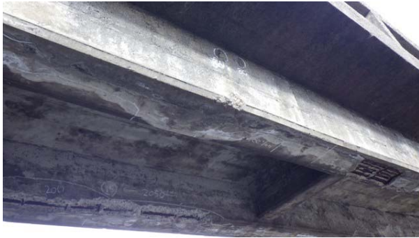
写真-8 日月橋桁下の状況
