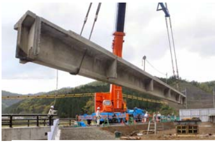
写真-2 桁取り出しの様子
