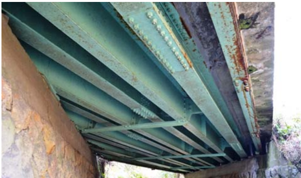
写真-1 対象橋梁(桁下の状況)
