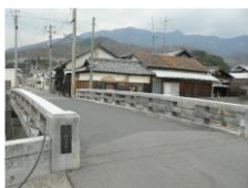
【事例2】単純RCT桁橋
