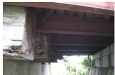
桁端部補強
