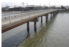
【事例2】単純H桁橋(歩道橋)
