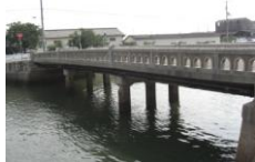
【事例1】単純RCT桁橋
