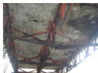
床板の損傷
