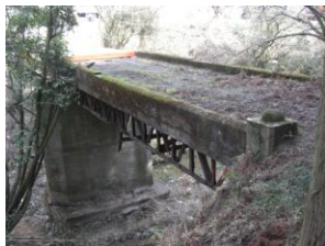
橋梁全体写真
