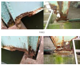
塩害による鋼橋の腐食 海岸より800m
