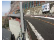
塩害による損傷の補修状況（海岸部の橋脚）
