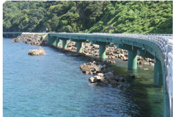
写真-7 過酷な塩害環境にある PCT 桁橋（福井県）
