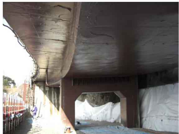
写真-8 気泡混合軽量盛土で土工化した橋梁（福井県）
