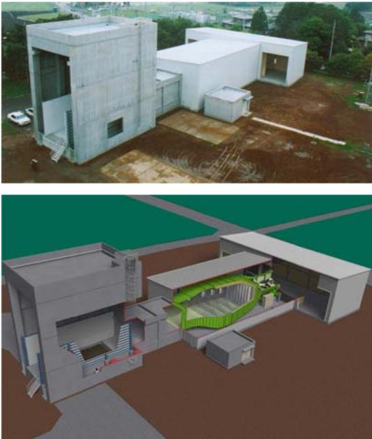
図2 火災風洞 (下段は透視図)
