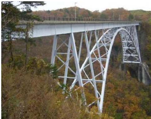
図3 槇木沢橋外観
