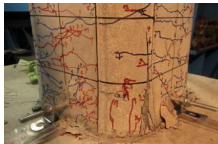
写真-3 地震応答载荷した場合の基部の損傷
