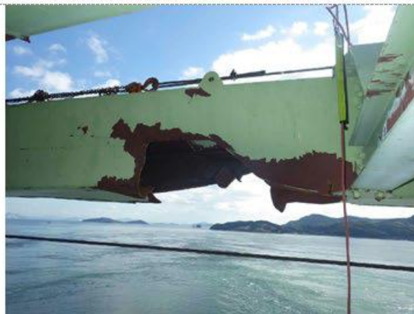
(c) 下弦材破断部（広島側） ←
