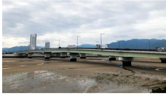
新八幡川大橋 実施中
