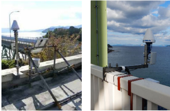
(a) 基準局 (起点側) (b) GNSS センサー (橋梁上)
