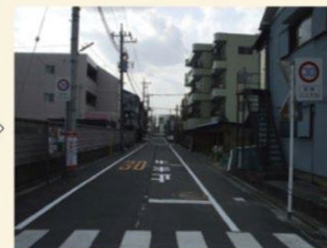
対策後 (中央線を抹消し路側帯を設置：背板付き区域規制標識を設置)
