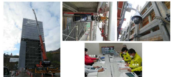
写真 1 北海道小樽市オフィス・二木町現場 阿部建設
