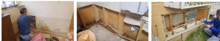
図6 壁内部空間の復旧(被災後16~23日目)
