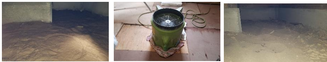
図3 床下空間の復旧（被災後2～16日目）
