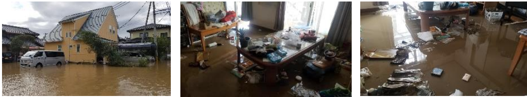
図1 室内空間の復旧（被災後1日目）
