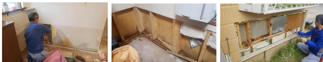
図6 壁内部空間の復旧（被災後16～23日目）
