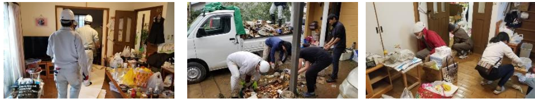
図2 室内空間の復旧（被災後2～4日目）
